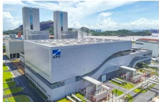
图：珠江 LNG 二期电厂
