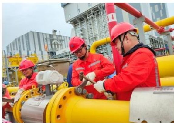
图：计量设备技术改造现场
