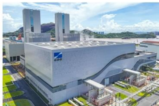
图：珠江LNG二期电厂
