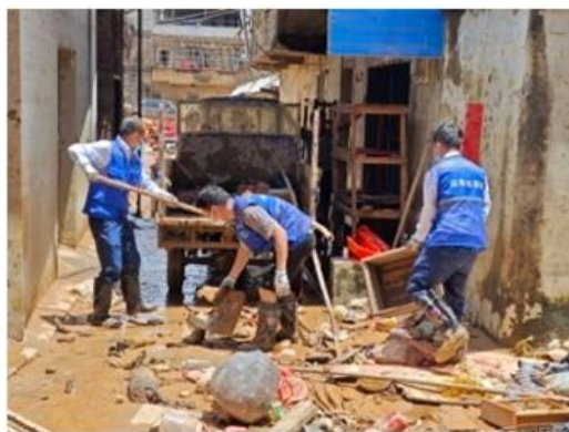
协助新铺镇抗洪救灾清淤现场
